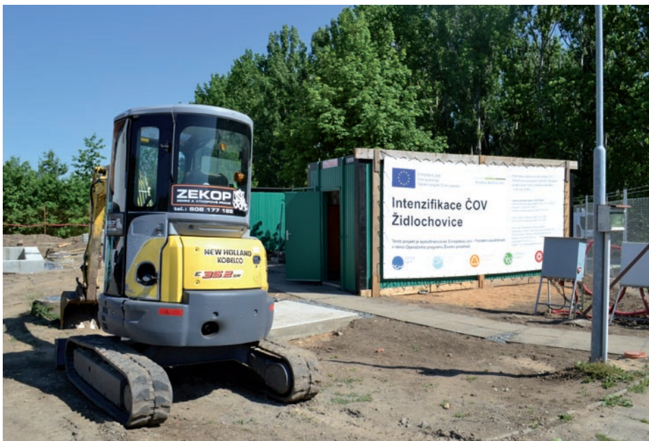
Rekonstrukce čistírny odpadních vod začala / foto: R. Nováková
