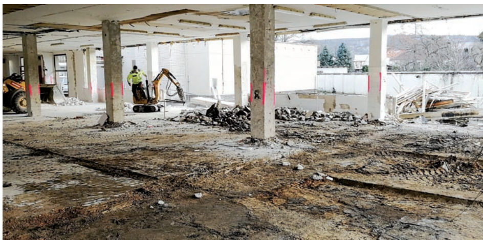
Jídelna, bourání původní podlahy / foto: J. Goš
