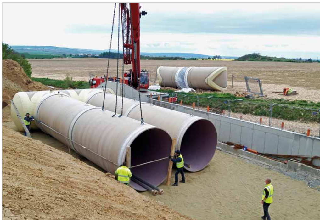
Montáž akumulčních nádrží nového vodojemu nad Hlinkami, 29. dubna 2020
